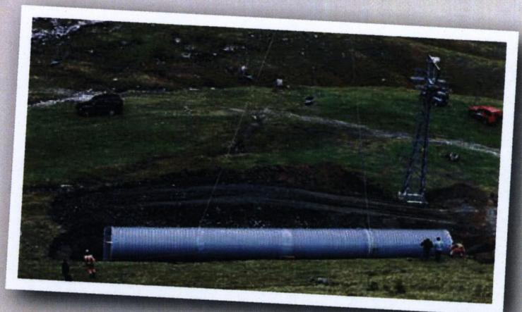
Atterrissage de précision et en douceur pour une masse de 3900 kg répartie sur 25 mètres de long.
