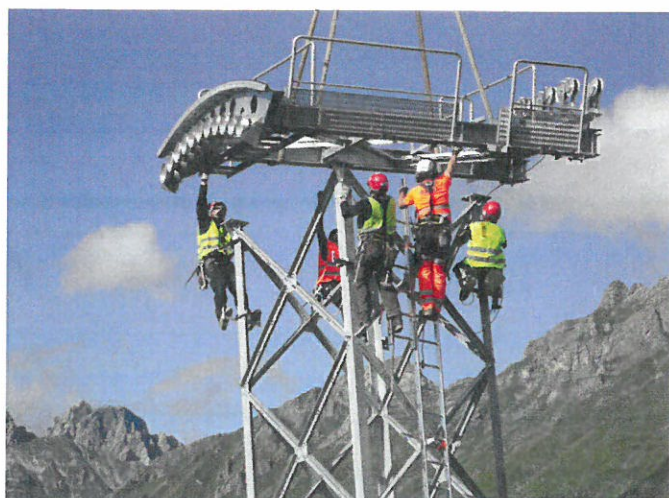
Fig. 5: Grand Clé – assemblage tête du pylône P3.
