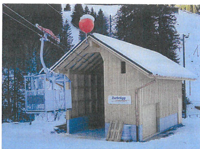
Fig. 6: Toumaley – station aval terminée.
