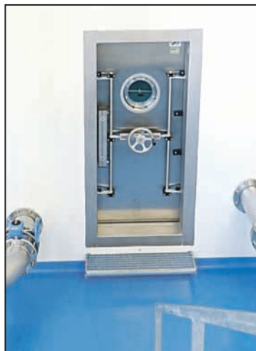
La porte blindée d'un réservoir y9
