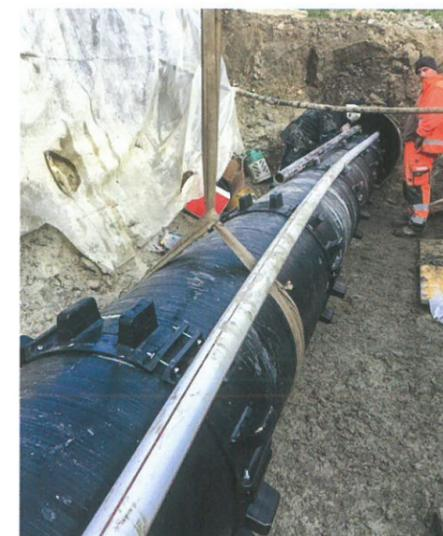
Lors du procédé de Micro-Tunneling, la conduite est tirée dans un tube de protection.
